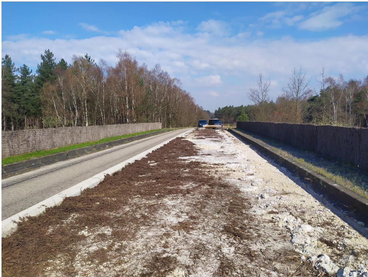
Figuur 2: Zicht op de bermbrug, in noordwaartse richting, op 19 maart 2020. Het faunadeel is nét ingericht: zand en heidemaaisel zijn net uitgespreid, maar dit is een te dun laagje substraat om bodemvallen in te graven. Er zijn wel 2 bodemvallen geplaatst in de smalle, grazige (groene) berm links op foto. © Jorg Lambrechts
