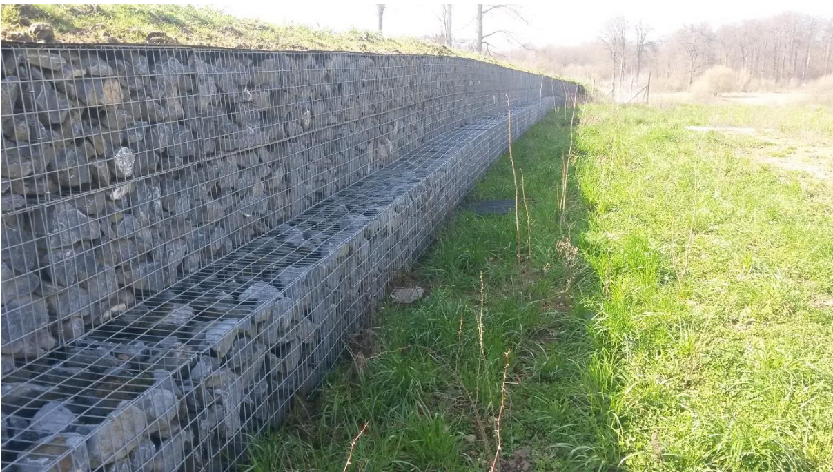
Figuur 4: Bodemval EG1 ligt tegen de schanskorven aan de zuidrand van het ecoduct. De schanskorven en de rest van het talud fungeren als geluids- en visueel scherm. Op enkele meters afstand ligt een reptielenplaat. 19 maart 2019 (foto: Jorg Lambrechts).
