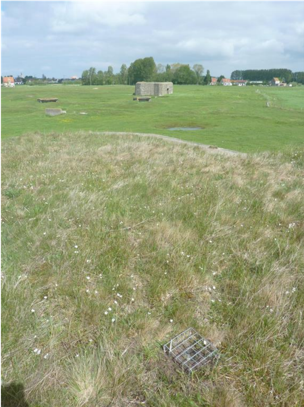
Figuur 8: De ene bodemval op het dak van de commandobunker is een extra tov het voorziene en is slechts korte tijd opgesteld. Het betreft locatie SB6. Foto Wim Boydens.
